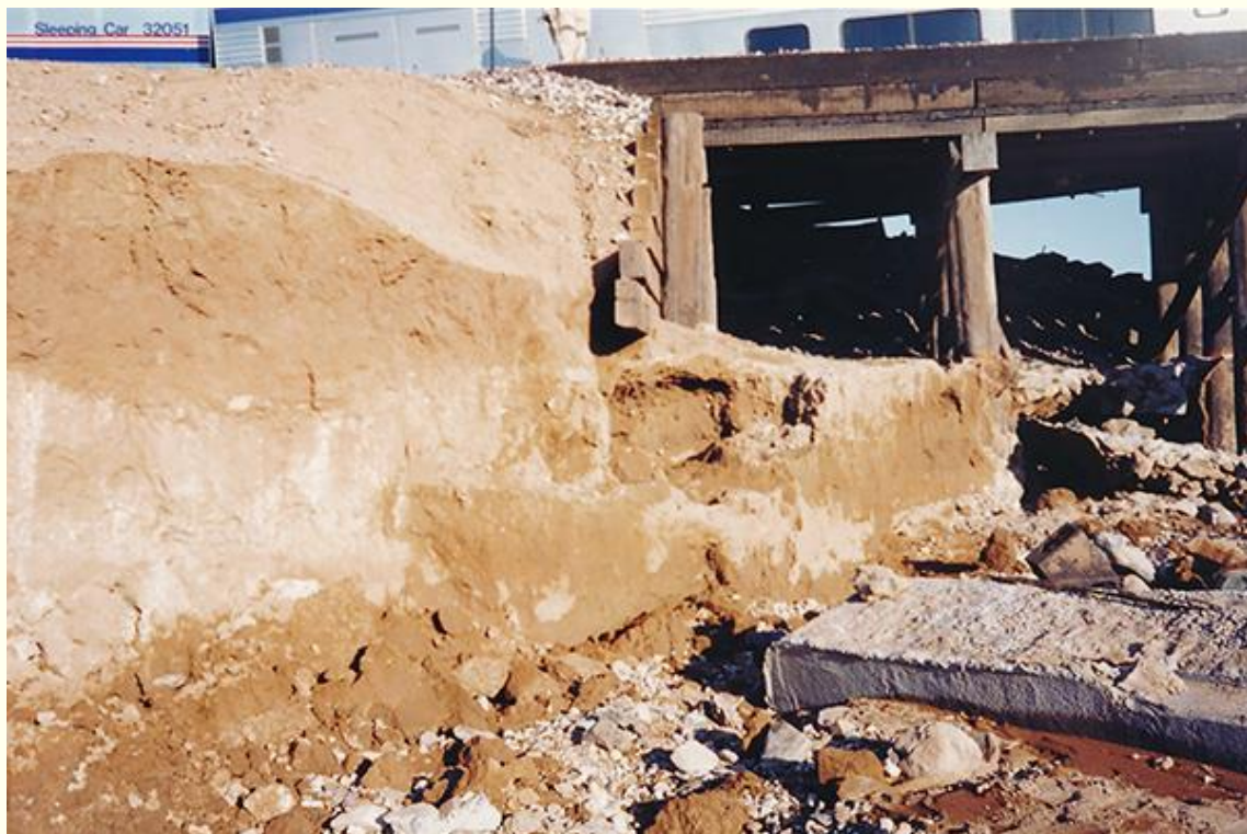
Fig. 2 Falla de puente de ferrocarril cerca de Kingman, Arizona, agosto de 1997.
